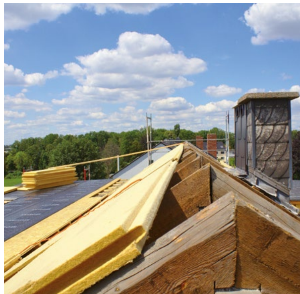
Mit der Dämmung von Dächern und Fassaden im Zuge der energetischen Sanierung lässt sich auch der sommerliche Wärmeschutz verbessern. (Foto: © Marco Becker / stock.adobe.com)
