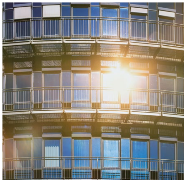
Mit Jalousien, Sonnenschutzglas oder -folie und zahlreichen weiteren Maßnahmen lässt sich der Wärmeeintrag in Gebäude verringern. (Foto: © MATTHIAS BUEHNER / stock.adobe.com)
