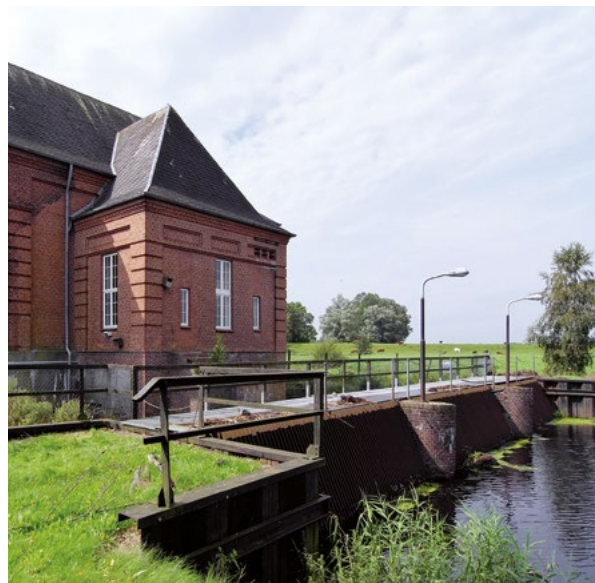
Das Schöpfwerk Steinschleuse an der Eider leistet einen Beitrag zur Entwässerung der Niederungsgebiete im Bereich des Eider-Treene-Verbands. (Foto: © Rainer Knäpper / Free Art License, ( http://artlibre.org/licence/lal/en/ ))
