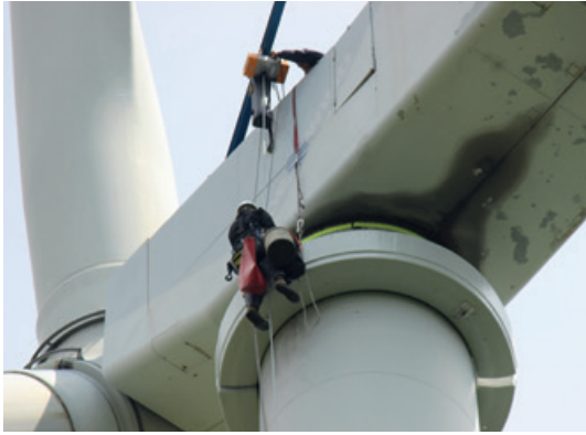
Abbildung 6: Externes Auffang- und Sicherungssystem für Windenergieanlagen (Quelle: Rotor-Rope GmbH).
